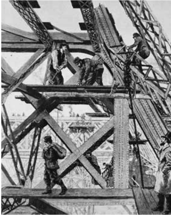
Construcción de la Torre Eiffel. París. 1888
